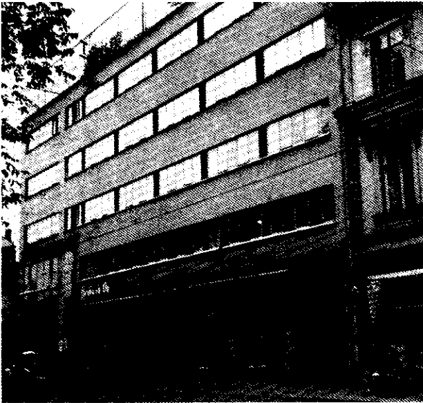
387. Sede del diario Turun Sanomat, exterior, 1928-1930.
