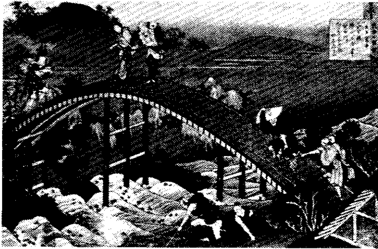
289. Puente de maderas japonés del siglo XV.
