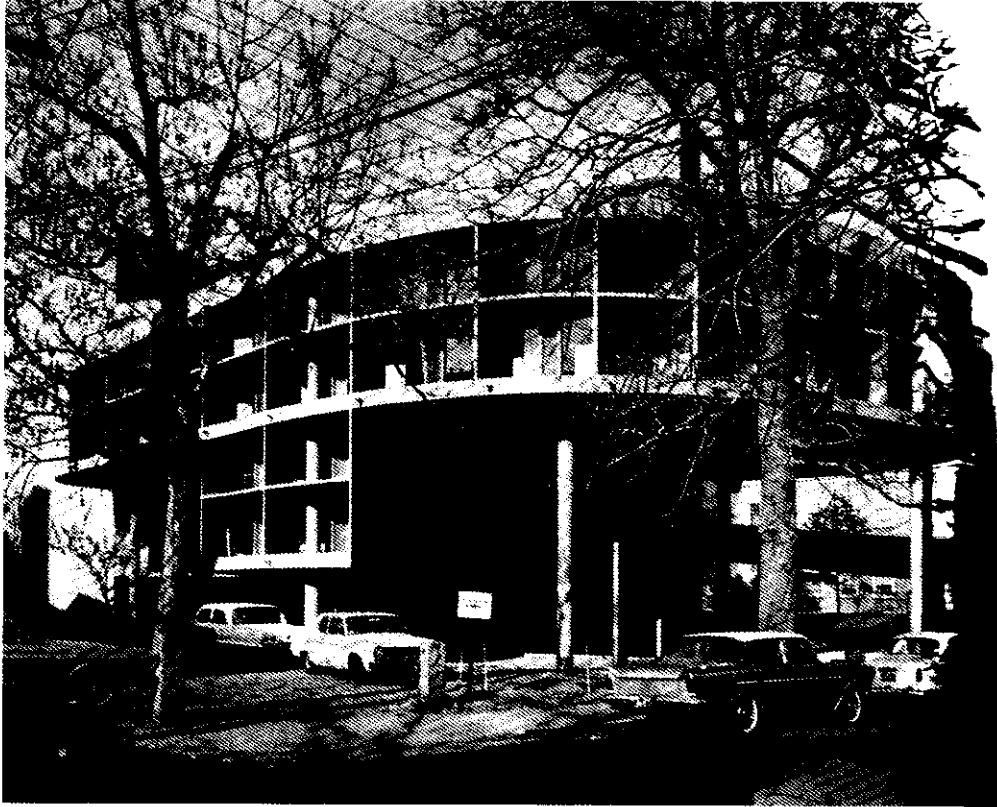
333. Carpenter Center for Visual Arts, Universidad de Harvard, 1963. El taller de estudios tridimensionales sobresale hacia delante (véase la planta de la figura 332). La rampa es visible al fondo, por debajo del taller, a la derecha.
